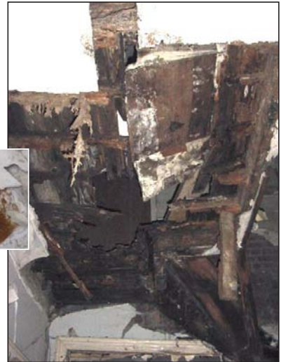
Plancher dégradé par les mérules
