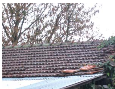
tuiles à remplacer
